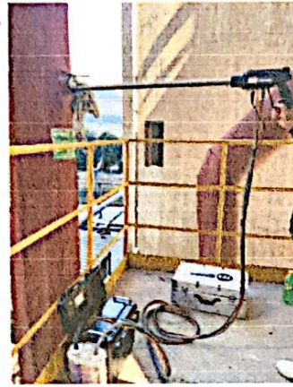
K2线立磨袋收尘排气筒出口
